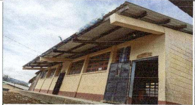
Foto 2: Pintura en muros exteriores y de puertas - Módulo II
