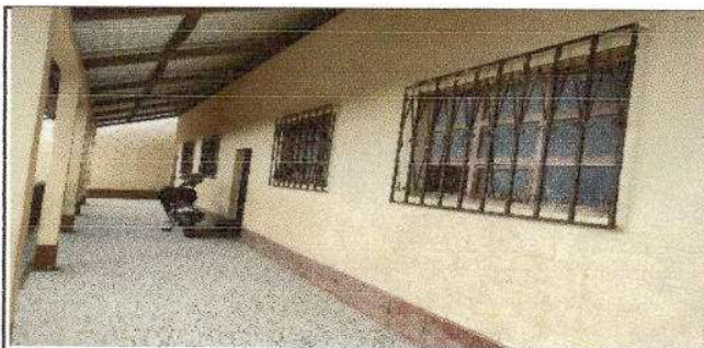
Foto 5: - Mantenimiento a balcones de metal Módulo II
